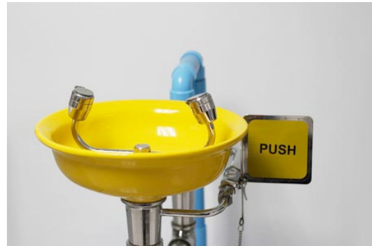
Estaciones de lavado de ojos deben cumplir con los requisitos de la norma ANSI Z358.1
