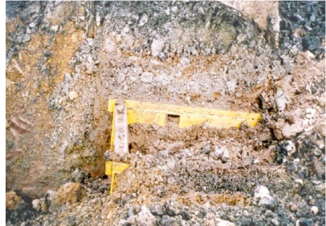
Dos trabajadores resultan muertos cada mes a causa de colapsos de zanjas
