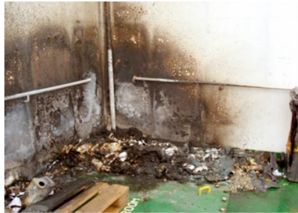
Incendio Causado por Ignición Espontánea (Trapos Oleosos)
